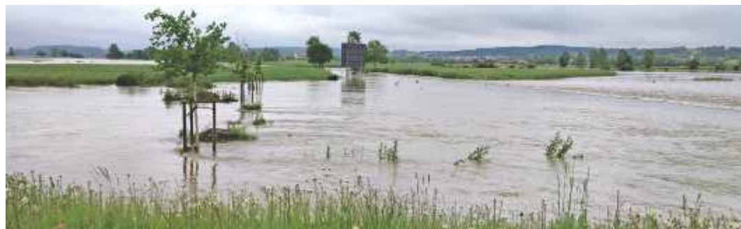
Die westliche Umfahrung von Thannhausen (B300) wurde durch die vom neuen Drosselwerk am südlichen Mindelzufluss umgeleiteten Wassermassen überspült und wird vorerst wohl noch gesperrt bleiben (Bild: Margrit Jordan)
